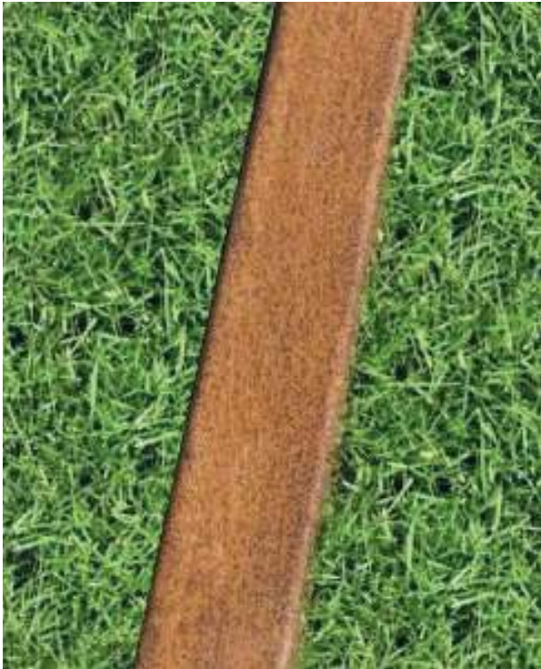
Afbeelding 18. Referentiebeeld van een cortenstalen rondlopende band (20cm breed). De cirkel van 5 meter doorsnede is een verwijzing naar de voormalige zonnewijzer.
