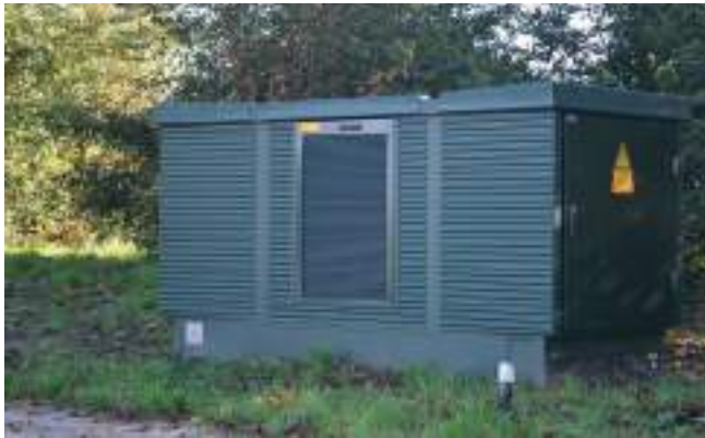
Afbeelding 26. Referentiebeeld transformator, Diabolo SHL groen, bron: alfen.com
