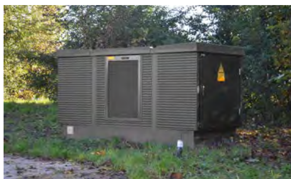
Afbeelding 22. Kleurgebruik voor elementen met referentiebeeld transformator in kwartsgrijs.
