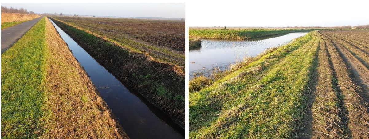
Figuur 5 Links de sloot aan de westzijde met het steile talud en diepe profiel. Rechts de Slochter AE die aan de zuidzijde van het plangebied stroomt.
